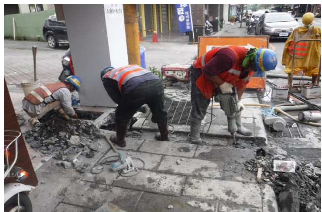
台水公司辦理老舊鉛管汰換作業情形 (台灣自來水公司提供)
