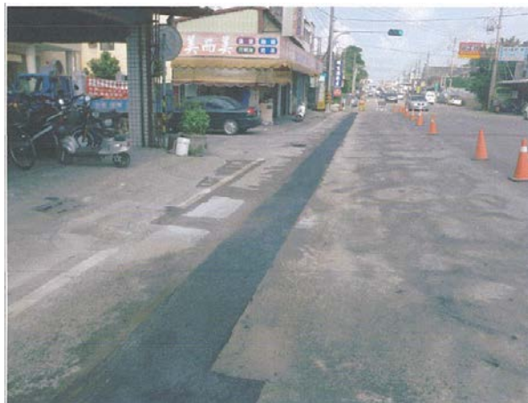
縣道148線埋設天然氣管線工程(施工後) (彰化縣政府提供)
