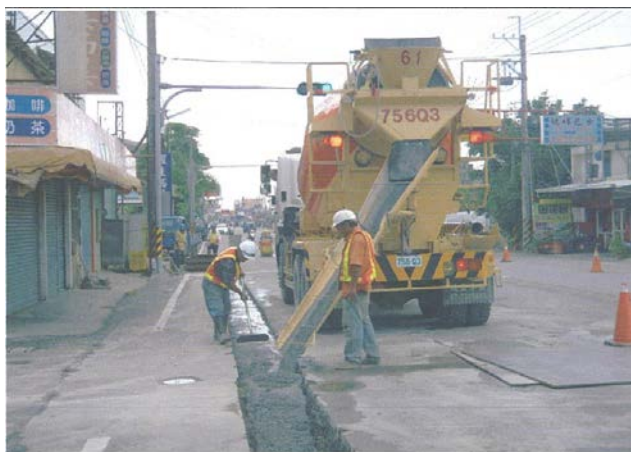
縣道148線埋設天然氣管線工程(施工中) (彰化縣政府提供)
