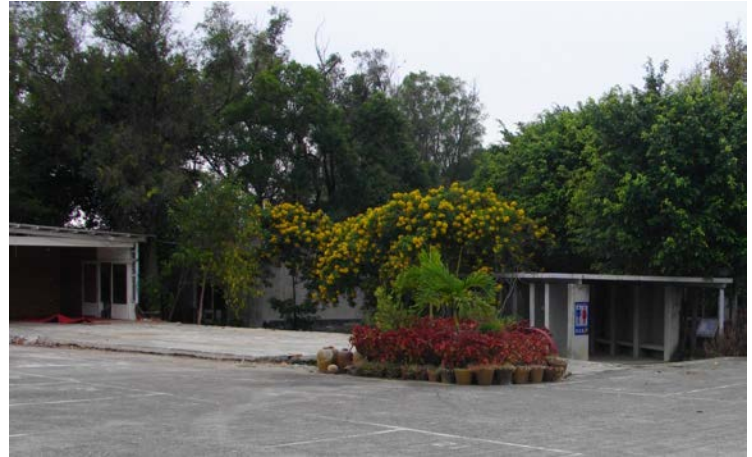
映象園區內大型違建物已拆除完畢
