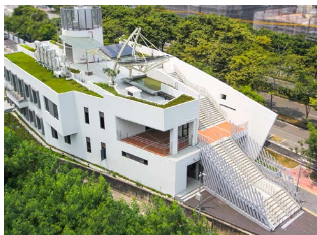
臺中市廊子水資源回收中心 (臺中市政府水利局提供)
