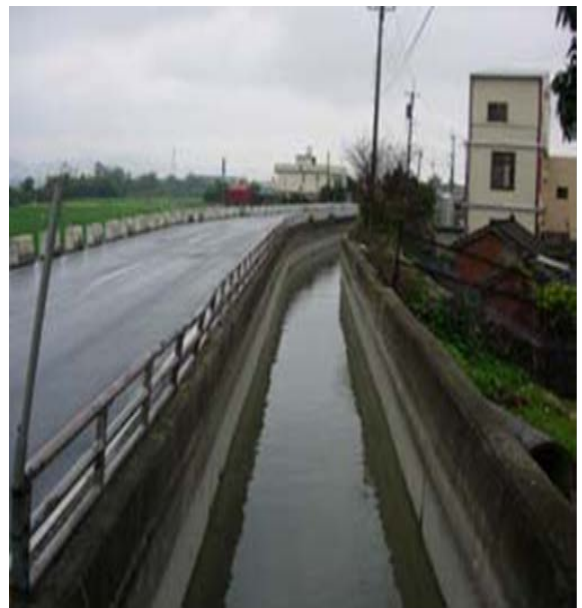
臺中市神岡區浮圳路拓寬改善工程 (臺中市政府建設局提供)
