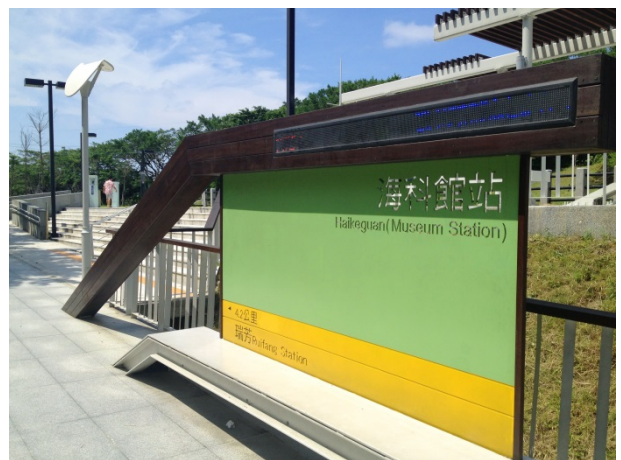
深澳支線海科館站啟用 （國立海洋科技博物館提供）
