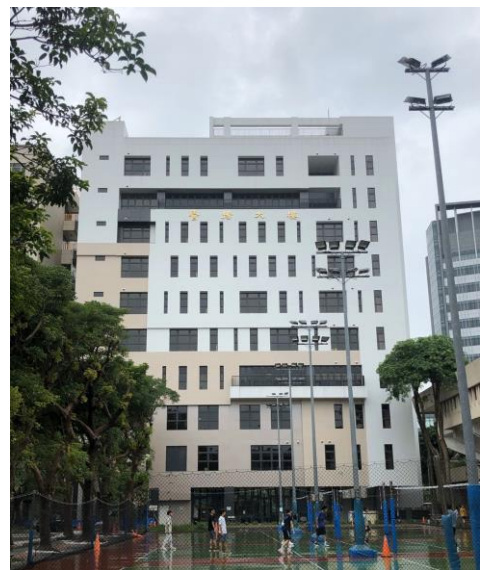
臺灣科技大學醫揚大樓 (臺灣科技大學提供)
