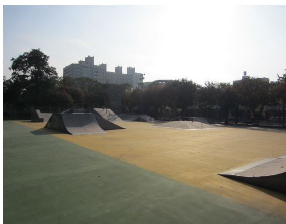
極限設施場整修活化前情形 (高雄市政府養工處提供)
