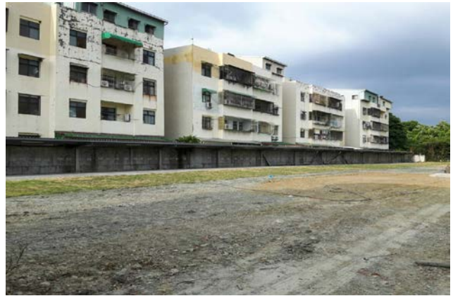
嘉義市志航國小志勤樓拆除整地工程現況 （嘉義市志航國小提供）
