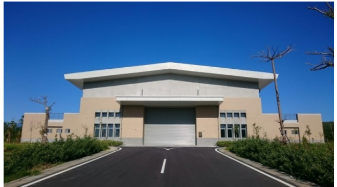
新建發修棚廠外觀 (國防部軍備局工程營產中心提供)
