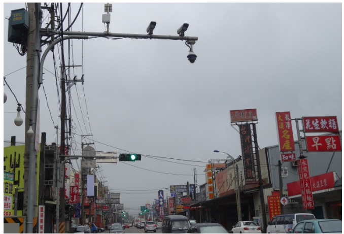
桃園市道路設置之監視錄影系統 (105年5月24日拍攝)
