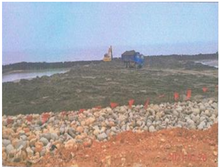
新竹縣政府工務處施作海岸養灘作業 （新竹縣政府工務處提供）
