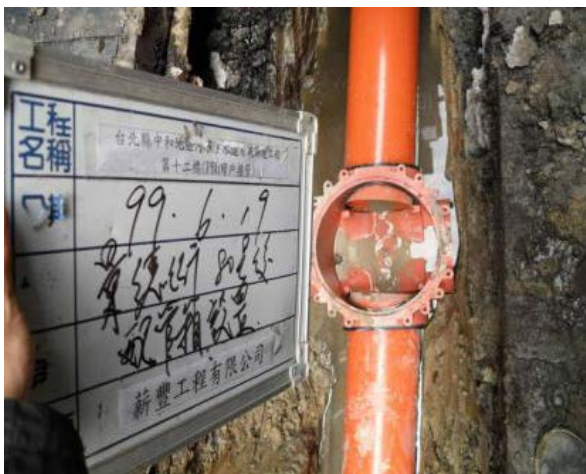
配管箱設置 (營建署提供)
