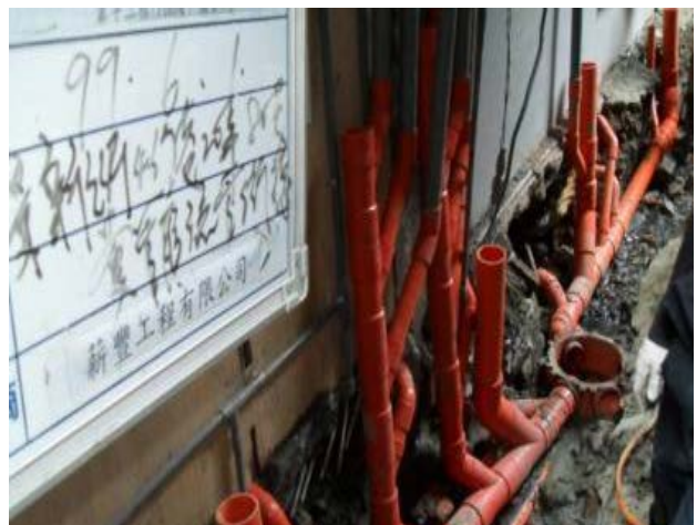
用戶接管工程 (營建署提供)
