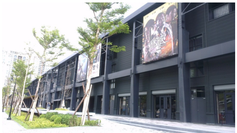
標租活化後之台鋁廠房及土地使用現況 (高雄市政府都市發展局提供)
