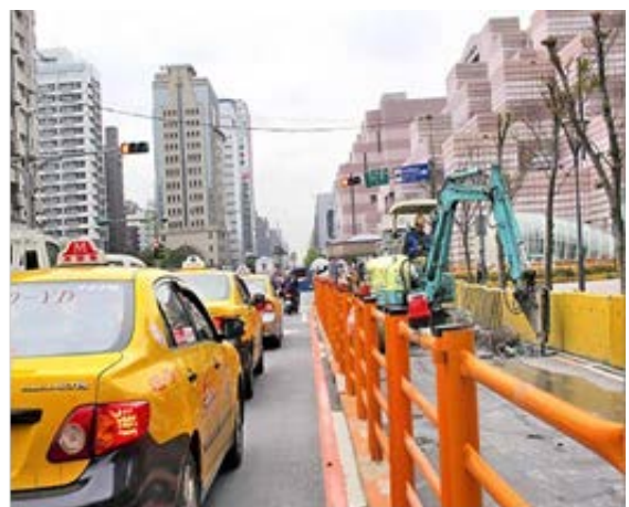
臺北市道路挖掘施工情形 (臺北市工務局新建工程處提供)
