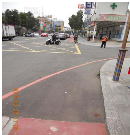
自行車道於路口未施作穿越道 (105 年 3 月 30 日拍攝)
