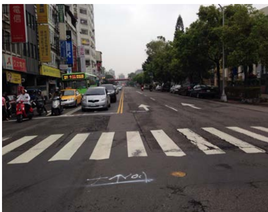
臺中市市區道路施工前 (臺中市政府建設局提供)
