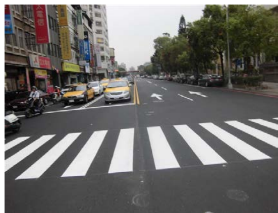
臺中市市區道路施工後 (臺中市政府建設局提供)
