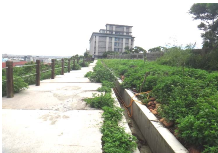
新竹縣山坡地住宅社區之擋土牆邊坡新設截流溝 (新竹縣政府工務處提供)
