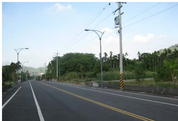
南投縣投 25 線道路拓寬工程完工通車 (南投縣名間鄉公所提供)
