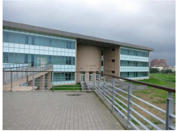
臺中市大雅區生命藝術館現況 (臺中市大雅區公所提供)
