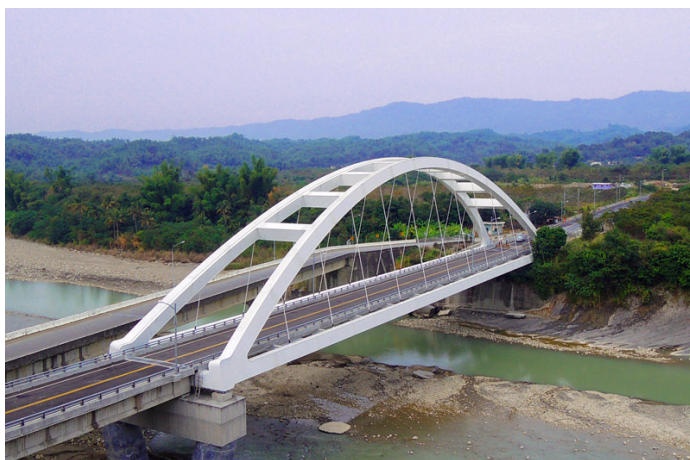
高雄市杉林大橋(重建後) (高雄市政府新聞局提供)
