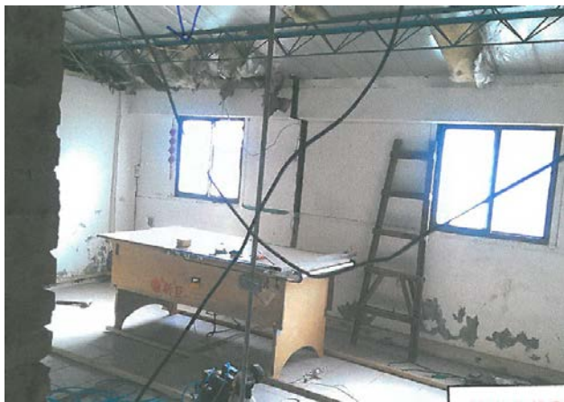
臺北市建築管理工程處辦理違建專案拆除情形 (由臺北市建築管理工程處提供)
