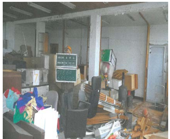
臺北市違章建築拆除現場 (臺北市建築管理工程處提供)
