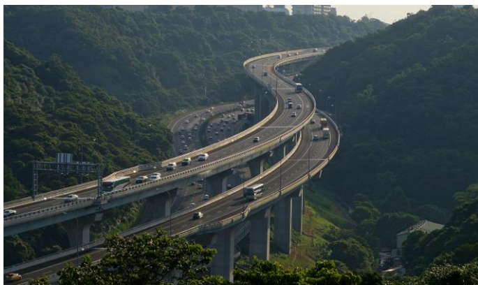
國道高速公路五楊高架橋段 (擷取自交通部高速公路局網站)
