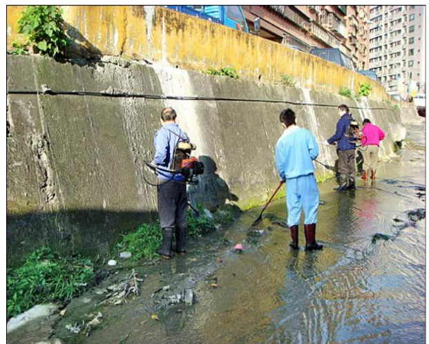
新北市里基層工作經費－溝渠疏通情形 (新北市政府提供)
