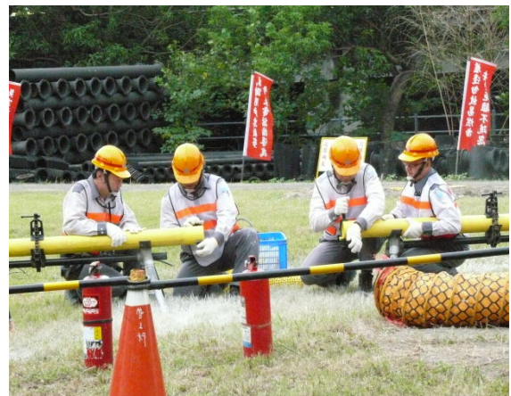
臺北市瓦斯管線檢修情形 (臺北市產業發展局提供)
