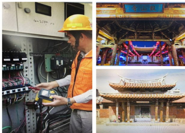
彰化縣鹿港龍山寺電路巡檢作業情形 (彰化縣文化局提供)
