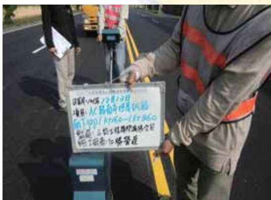
圖 4 路面增加 AC 鋪設厚度，完成後以平坦儀檢測
