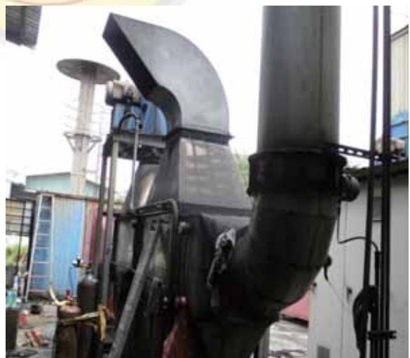
圖 2 空污防制設備損壞閒置
