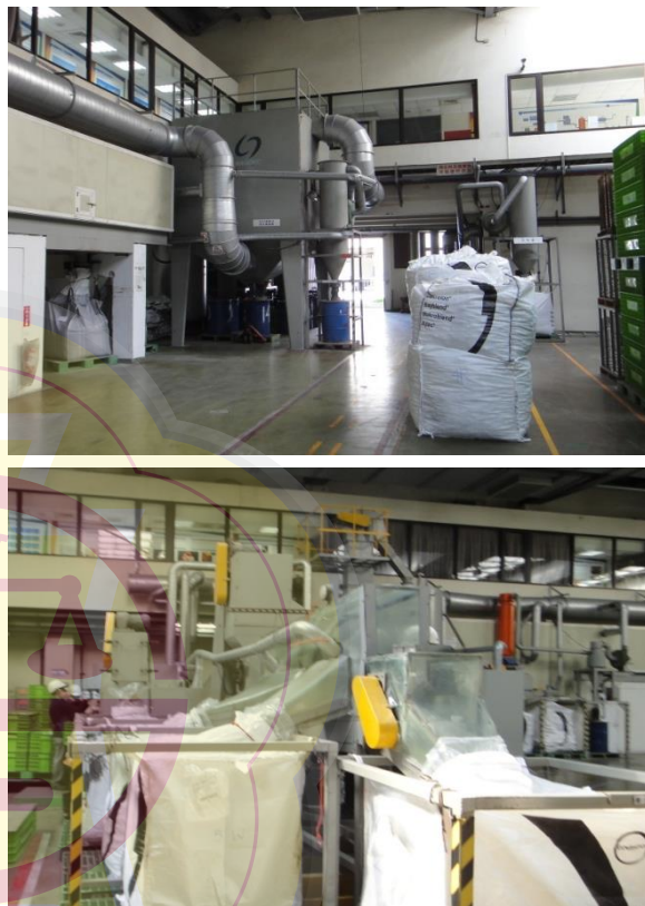
桃園環保科技園區研發大樓使用情形(106年7月) 資料來源：桃園市政府環境保護局提供。
