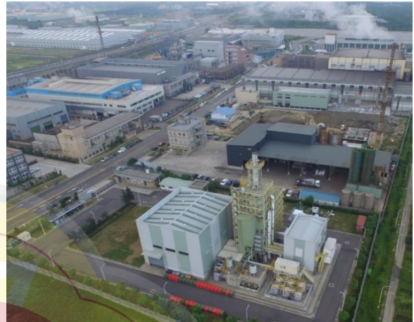
桃園環保科技園區量產實證區使用情形(106 年 7 月) 資料來源：桃園市政府環境保護局提供。
