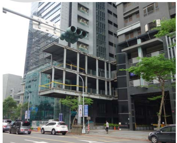
曼哈頓金融大廈連接遠東板橋購物中心興建中之空橋
