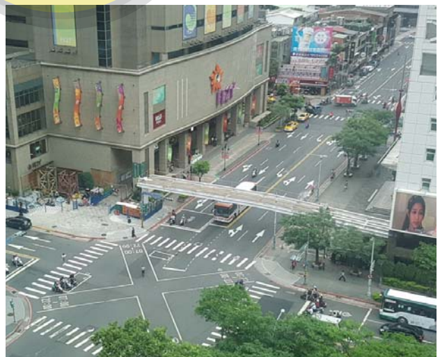
市政府稅捐稽徵處連接遠東板橋購物中心未完工之空橋興建情形
