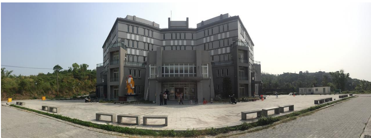
納骨塔工程完工後全景
