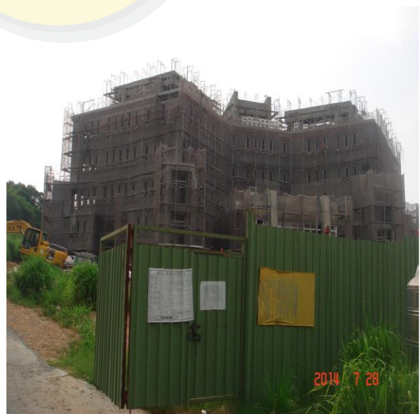
納骨塔工程施工中情況
