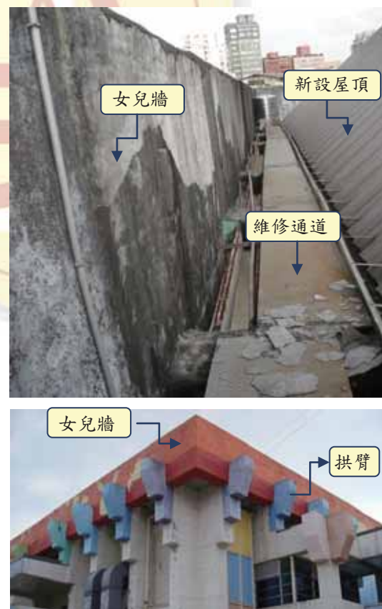
圖 4 明日世界館女兒牆及維修通道 （上圖為屋頂狀況，下圖為該館側視圖）
