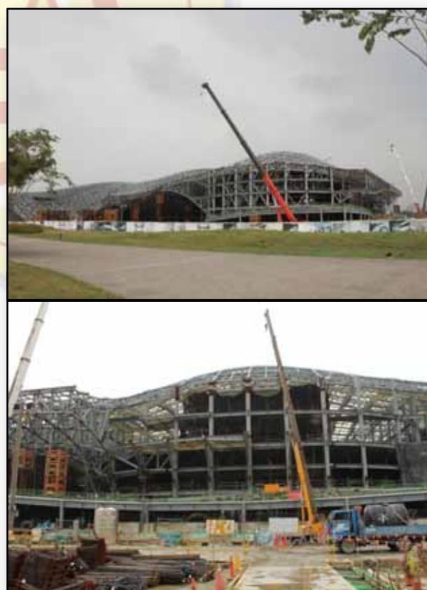
圖 16：衛武營藝術文化中心現場施工圖
