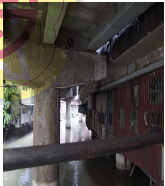
圖 5 中正高架橋採碳纖維貼片包覆補強現況圖
