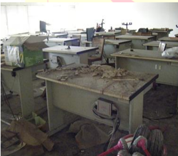
照片來源：民國 98 年 5 月 23 日實地勘查拍攝 圖 5 教學大樓 3 樓訓練教室實況
