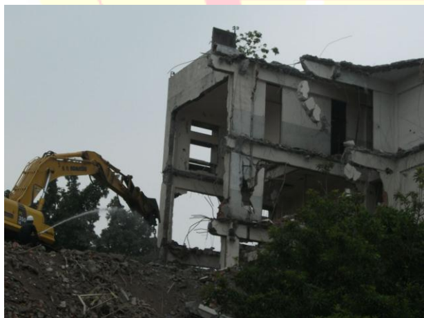
照片來源：高雄市政府勞工局訓練就業中心 圖 6 小港區訓練場地學員宿舍拆除實況
