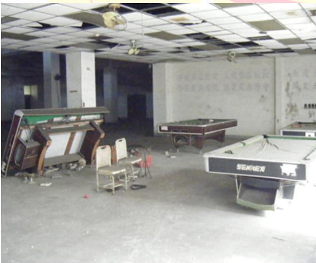
照片來源：民國 98 年 5 月 23 日實地勘查拍攝 圖 2 禮堂地下室實況
