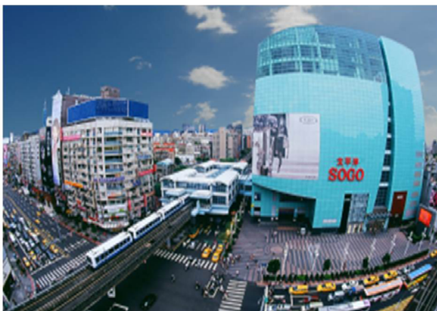
忠孝復興站聯合開發大樓外觀 資料來源：捷運局提供。
