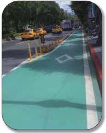
照片來源：臺北市交通管制工程處提供 圖 3 自行車專用道彩色地坪
