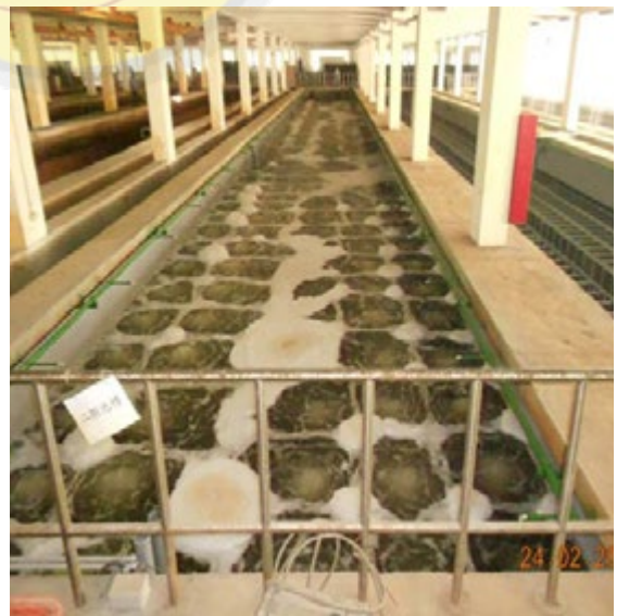
圖6 污水處理廠房曝氣池(使用中)
