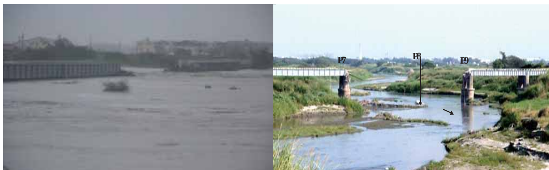
圖 5 虎尾糖廠鐵橋毀損情形
