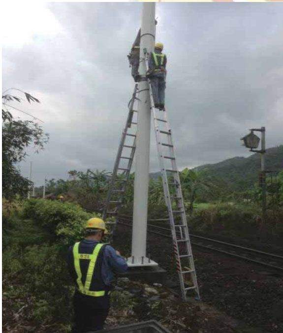
吉安-志學間電力桿安裝
