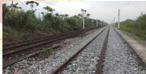
豐田-溪口主吊線架設
