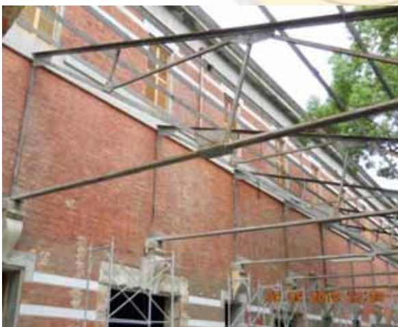
資料來源：99 年 9 月現場勘查所攝 圖 7 修復中之樟腦廠
