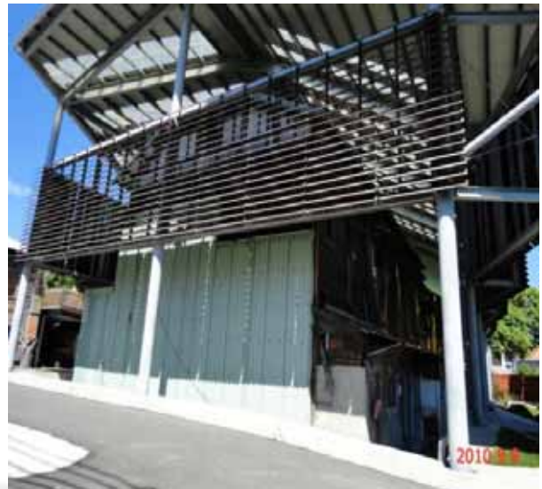
圖10 鐵道部食堂古蹟加固工程(上方加蓋部分)
