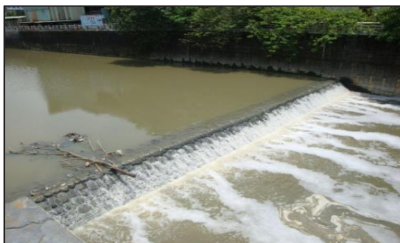
鳳山溪於大智陸橋上游河段原設置攔水堰及河道曝氣設施。 資料來源：水利局提供。
