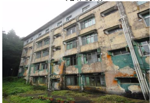
圖 5 阿里山閣大飯店整修前外觀 (舊館後側)
