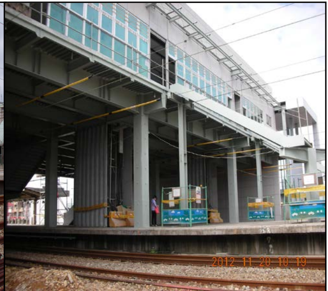
本案第二期工程施工情形 (照片來源：臺鐵局，101年11月20日拍攝)
