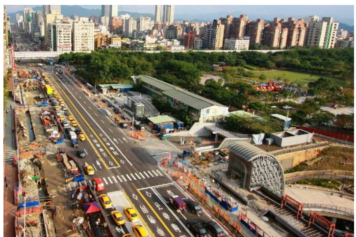
臺北捷運信義線CR580A區段標102年1月施工情形 (捷運局南工處提供)
