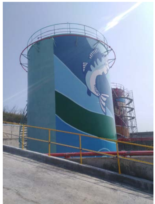
七美發電廠新建油槽 (台電公司提供)
