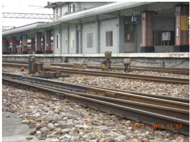
環島鐵路整體系統安全提昇計畫 花蓮站道岔改善工程
