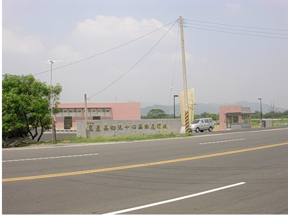
臺南縣農產物流中心蒸熱處理廠大門 (臺南市政府農業局提供)
