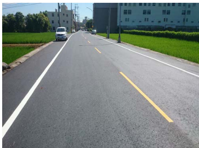
新竹縣執行道路整平計畫改善後現況 （新竹縣政府提供）
